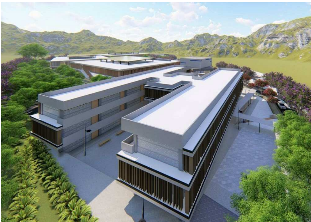
VISTA LATERAL ESTE
