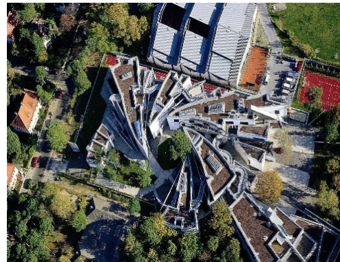
Figura 5: Heinz Galinski Schule (Alemania, 2006) Fuente: Matemolivares "Zvi Hecker", 2013. http://matemolivares.blogia.com/2013/042001-zvi-hecker-el-maestro-de-la-geometria-aplicada-a-la-arquitectura..
