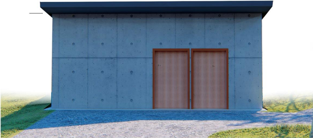
VISTA OESTE- EDIFICIO TRATADO DE DESECHOS
