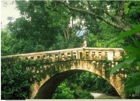
Foto No. 4 Puente Viejo "La Conquista" Fuente: OMP Quezaltepeque
