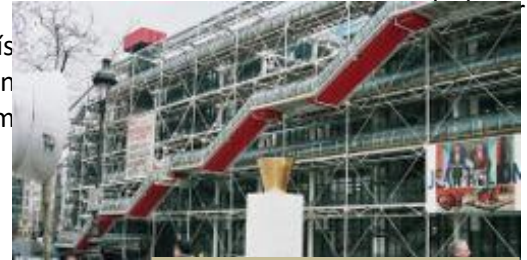
Vista de la fachada oeste del CENTRO GEORGES POMPIDOU
