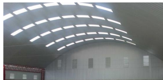
Cubierta tipo EMCO instalada.
