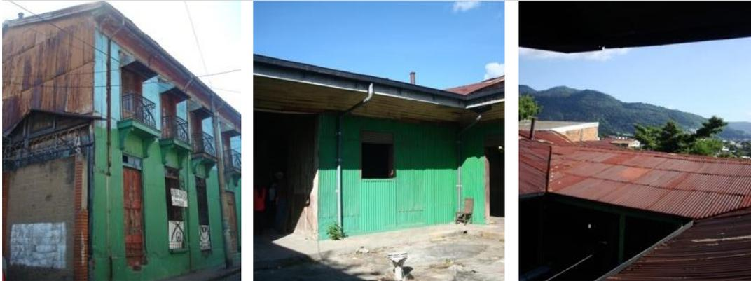
**Figura 73.** (Izquierda): Paredes exteriores de las crujías en el patio posterior. (Centro): Cubierta en crujías de un nivel en torno al patio central. (Derecha): Lámina exterior empleada en la fachada principal y en los laterales colindantes.
