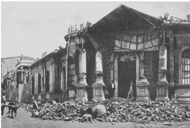
Lo que pone en evidencia el buen funcionamiento de algunos de los sistemas constructivos de la época, específicamente el compuesto de lámina troquelada y madera, que como se verá más adelante, llegó en algunos casos a concebirse de forma híbrida con materiales o sistemas locales como el bahareque:
