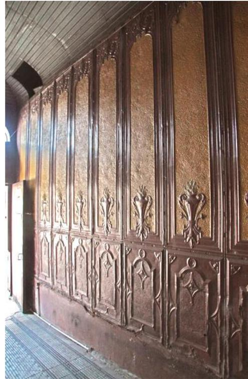
**Figura 12.** (Izquierda) Detalle de lámina troquelada en zaguán de la Casa 139 (desaparecida por desmantelamiento).
