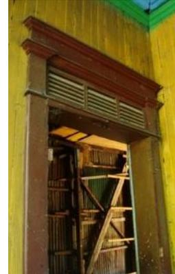
**Figura 72.** (Izquierda): Puerta-ventana en 2º nivel. (centro-izquierda): Puertas y ventanas en habitación 3. (centro-derecha): Puerta en habitación 8. (Derecha): Detalle de tímpano con celosía de madera para la ventilación natural del espacio en habitación 5.
