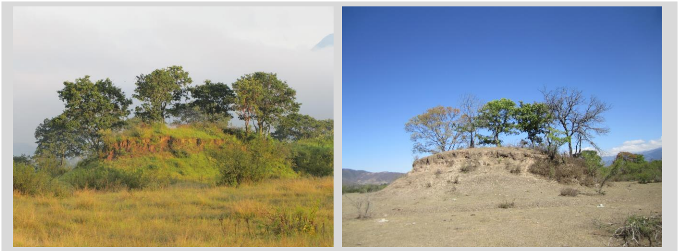
Figura III.11 Montículo 3. Se puede observar la erosión que presenta en la parte media de la edificación, donde sobresale material cerámico (fotografías: de León Mónica, 2012 y 2018).
