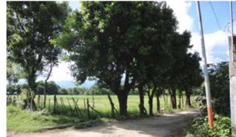
Poste de energía eléctrica cercano al terreno. Fotografía No. 5.2.6 F1
