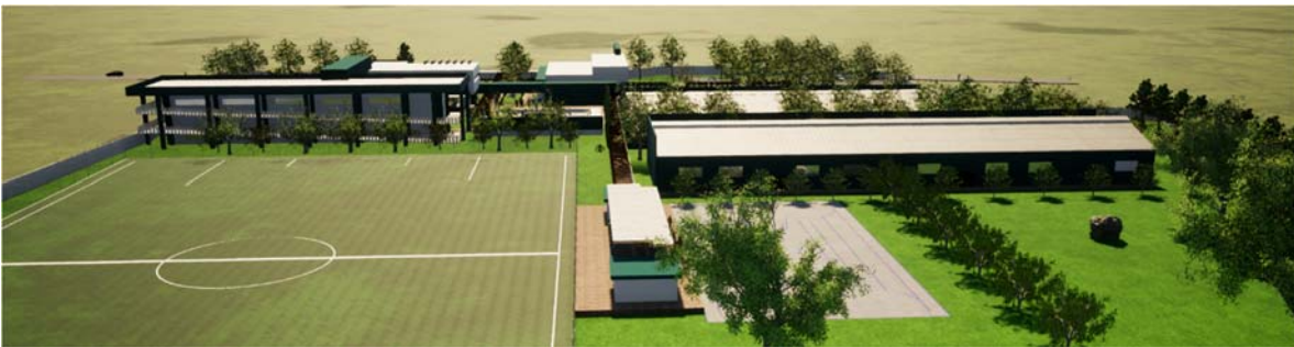
VISTA NORTE DE CONJUNTO
