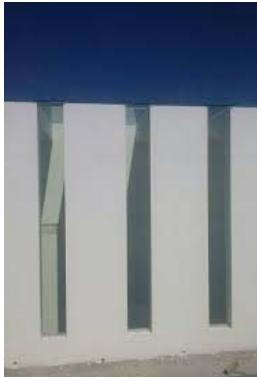
Ventanas tipo troneras. Fotografía No. 1.6.9 F1
