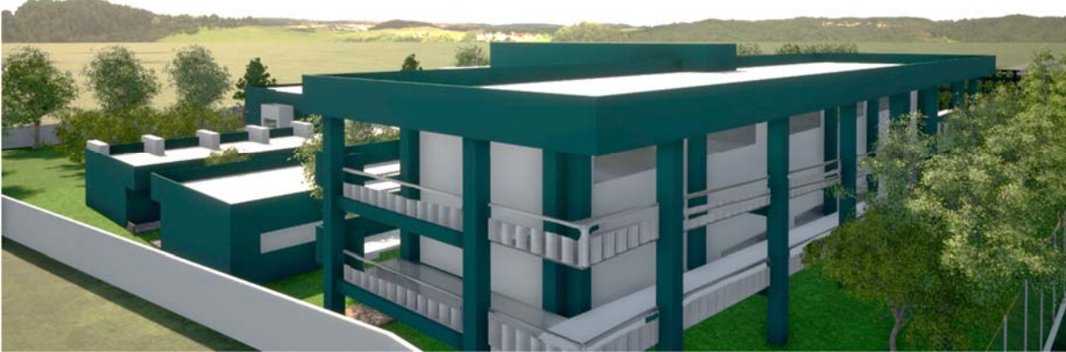
VISTA POSTERIOR DE EDIFICIO DE AULAS PURAS
