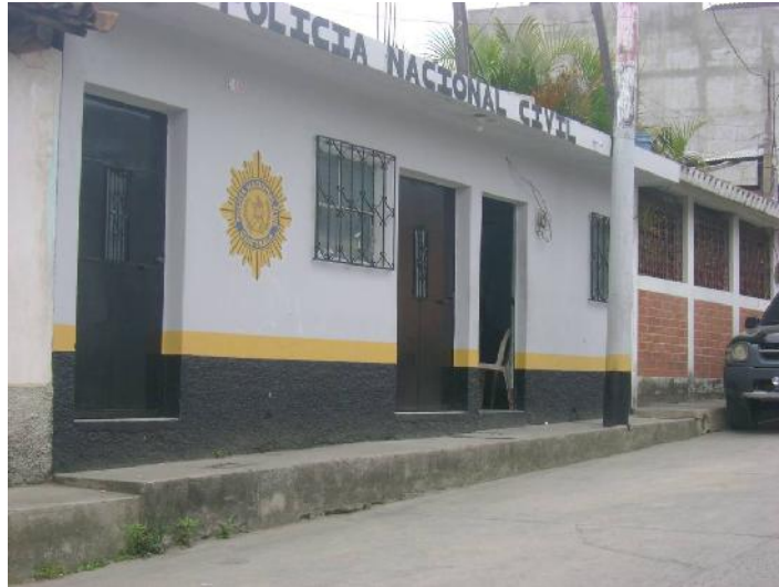
Figura 28. Subestación Policía Nacional Civil, Pachalum. http://www.tripmondo.com/guatemala/quiche/pachalum
