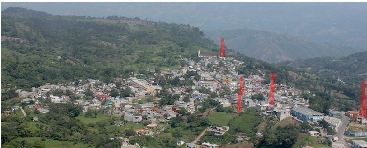
Figura 67. Alteración de la imagen urbana por torres de telefonía Dirección Municipal de Planificación
