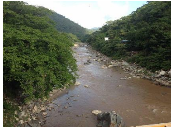
Figura 56. Puente río Motagua, Pachalum. Elaboración propia
