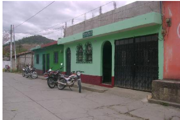
Figura 61. Vivienda típica del área urbana del municipio de Pachalum
