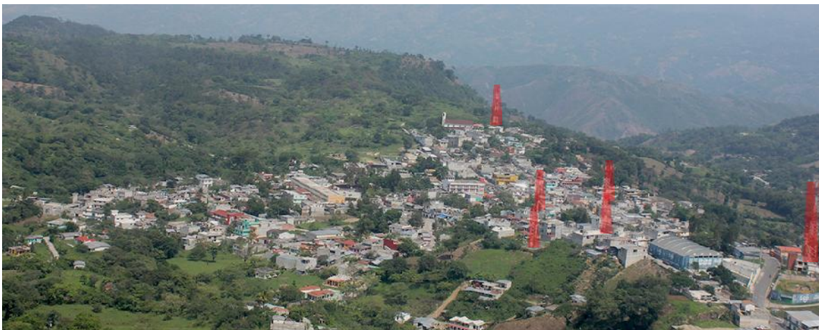
Figura 96. Alteración de la imagen urbana por torres de telefonía Dirección Municipal de Planificación.
