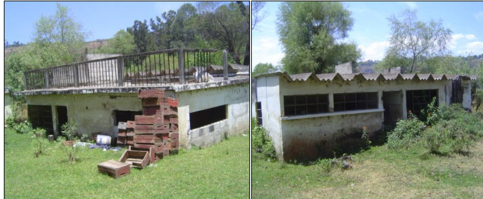
VIVIENDA DAÑADA EN AL ÁREA DE PLAYA DE ORO PARA LA TORMENTA STAN, (Fotos E. Varela 2008)
