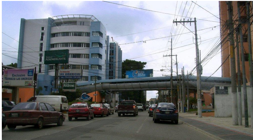
Imagen del Edificio del Centro Medico, y la Pasarela de servicio, que comunica con el otro edificio. Fotografía: David G. Cojolón A. (2012).
