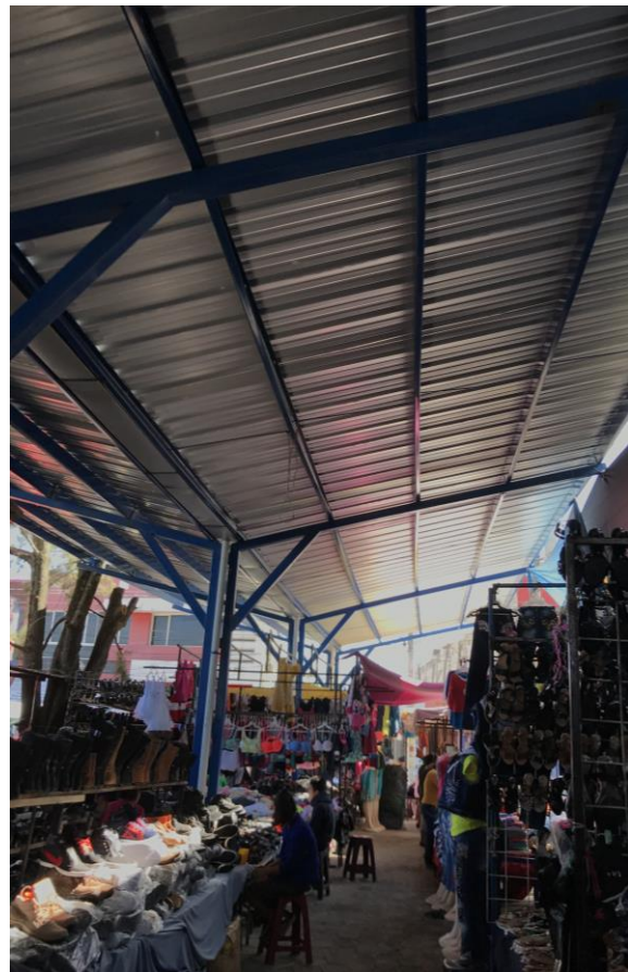
FOTOGRAFÍAS TOMADAS POR ING. JOSÉ MARIO RECINOS AQUINO, DIRECTOR MUNICIPALIDAD DE JALAPA, JALAPA. EN ENERO DE 2017
