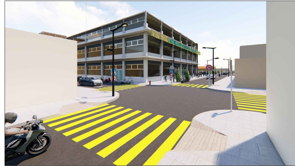
EN ESTA IMAGEN SE PUEDE APRECIAR LA VISTA DE LA INTERSECCIÓN DE LA 2A CALLE Y AV. CHIPILAPA EN DONDE SE COLOCARON RAMPAS PARA DISCAPACITADOS Y PASOS DE Y PASO DE CEBRAY ASI TENER COMPLETA MOVILIDAD PEATONAL
