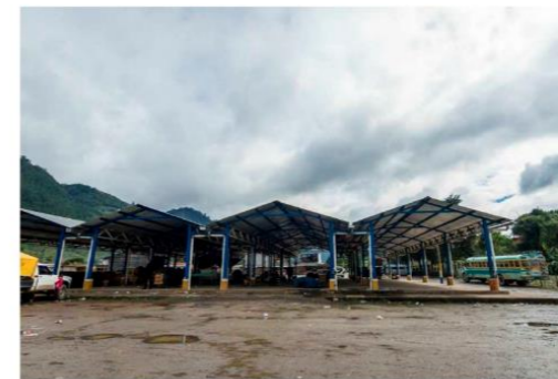
Fotografía 1 Se observa las 3 galeras que hay en el sitio.
