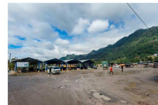
Fotografía 4 Se observa la infraestructura existente.
