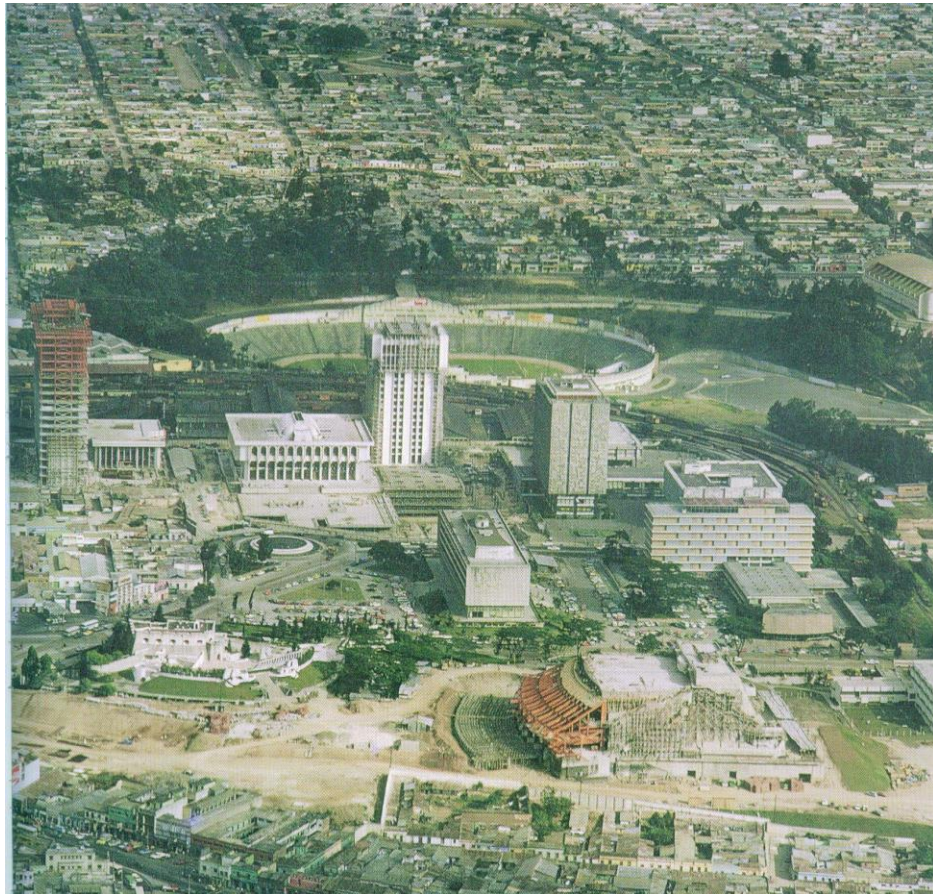
Ilustración 10 Vista aérea del Centro Cívico durante la construcción del teatro nacional
