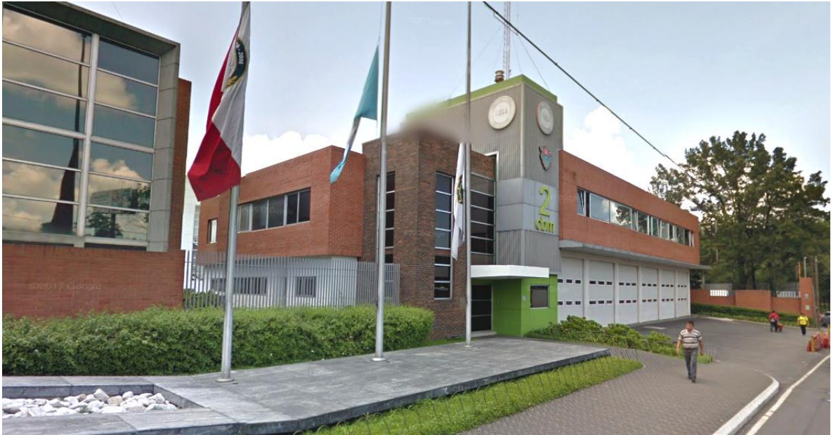
Imagen No.71 2ª. ESTACIÓN DE BOMBEROS MUNICIPALES
