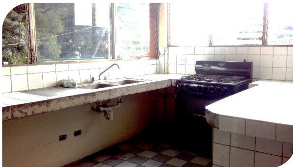
Imagen No.67 COCINETA
