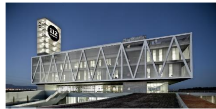
Figura 33 Ingreso fachada sur-oeste http://www.plataformaarquitectura.cl/cl/02-125303/edificio-112-acxt-arquitectos
