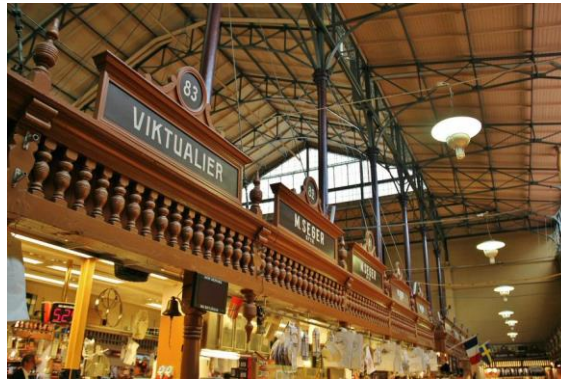
Imagen No. 45, observamos el techo del mercado, manejando estructuras metálicas y cubiertas livianas. Fuente: guiasparaviajar.com
