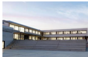
Imagen 8: Cancha polideportiva al edificio.
