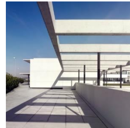
Imagen 10: Columnas y vigas del proyecto.
