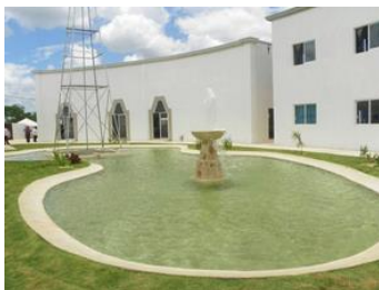
Imagen 12: Espacio de interconexión con uso de agua.
