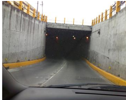
16. Paso a desnivel desde zona 12 a 13 calle
