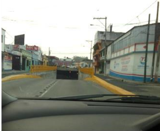
17. 12 calle ingreso a paso a desnivel
