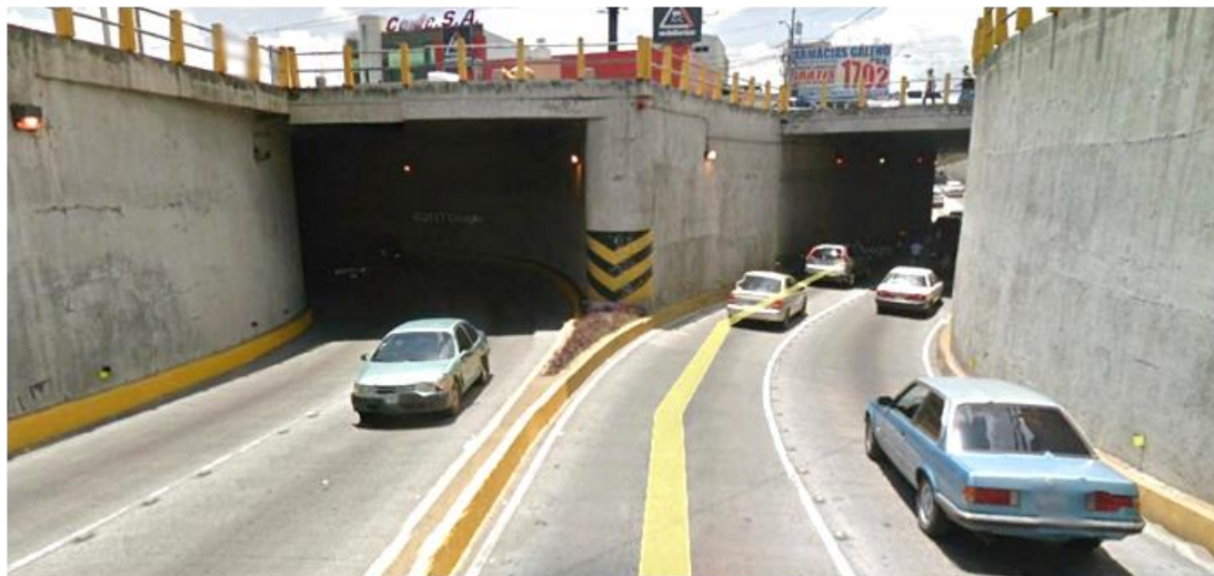
19. Paso a desnivel visto desde 13 calle hacia zona 12
