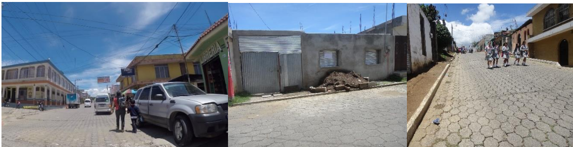
Figura 7. Situación actual del casco urbano de Zaragoza, la cual muestra la inexistencia de espacios públicos de calidad, que dignifiquen al peatón. Elaboración propia (Zaragoza, Chimaltenango, 2016).
