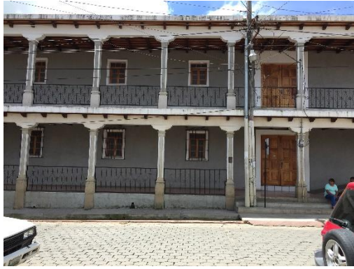
Figura 91. Salón comunal, Zaragoza, Chimaltenango. Fuente: Elaboración propia, 2017.
