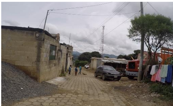
Figura 3. Fachadas de viviendas sin tratar estéticamente, sin áreas verdes, con construcciones inconclusas, sin acabados, con calles sin banquetas y sin pavimentar. Fotografía propia (Zaragoza, Chimaltenango, Guatemala, 2017).
