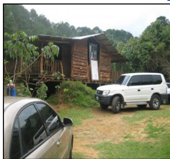
1. Parqueo de terracería Sin señalizar
