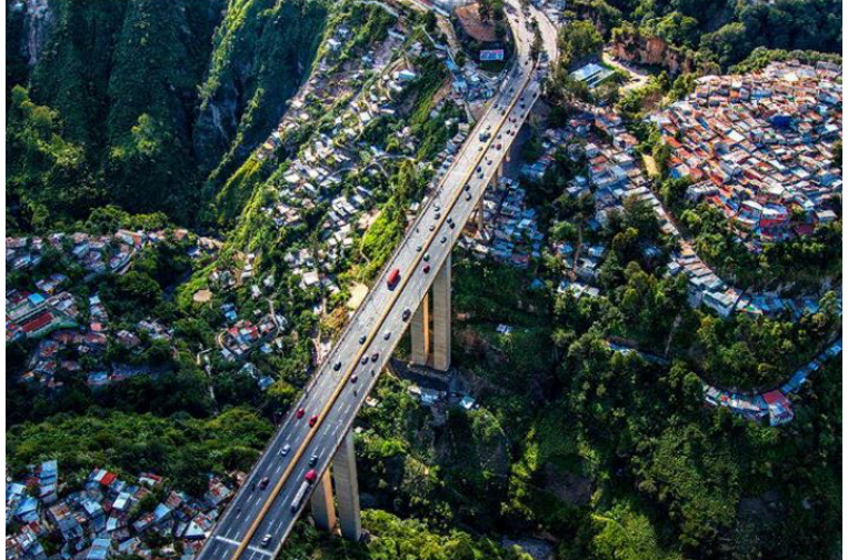
Figura 1. Vista aérea del puente conocido como "El Incienso"
