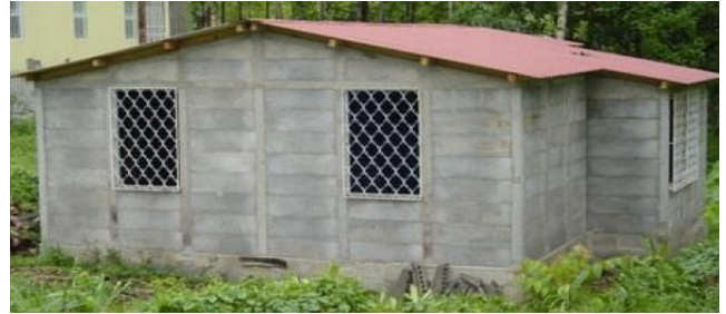
Figura 12. Vivienda con planchas de concreto prefabricado y lámina.
