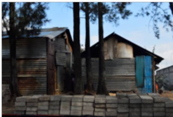
Figura 11. Vivienda construida con lámina y madera.
