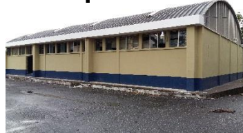
Imagen No 37 Rampa de revisión y área de carga y descarga
