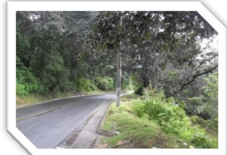
Servicio de electricidad y Teléfono
