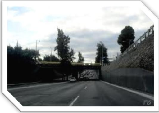
FOTOGRAFÍA No. 3: 31 Avenida Anillo Periférico hacia la USAC
