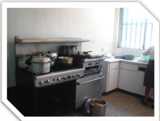
En la cocina se utilizan artefactos de cocina industrial, sin embargo las mesas de trabajo son inadecuadas y escasas.
