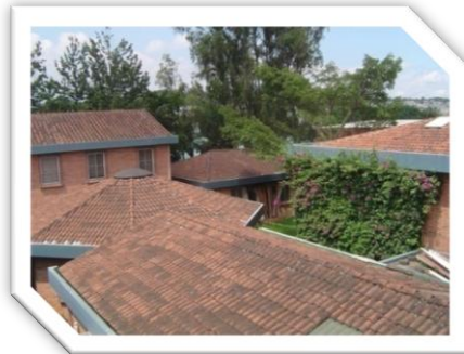
Se observa la integración de vegetación al diseño de los edificios.
