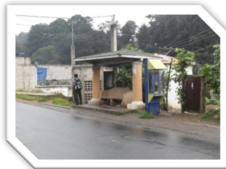
Parada de Ingreso a Santiago Sac. FOTOGRAFÍA 2
