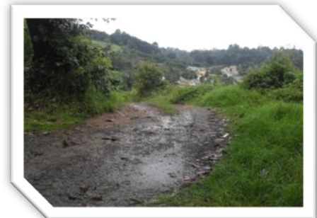
Acceso No. 2 en el terreno
