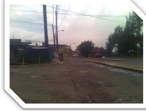
FOTOGRAFÍA No. 4: 31 Avenida Hacia Ciudad de Plata II
