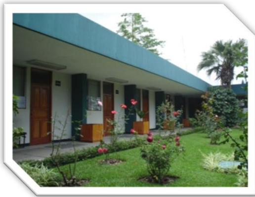
Existencia de áreas verdes exteriores que proporcionan iluminación y ventilación natural a los ambientes.
