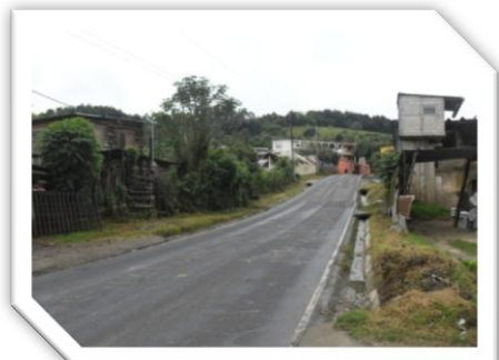
Carretera para San Lucas y Guatemala. FOTOGRAFÍA 10
