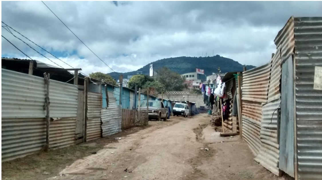
Alteración de albergues tipo a causa de su deterioro. Imagen 10: Fuente, propia.
