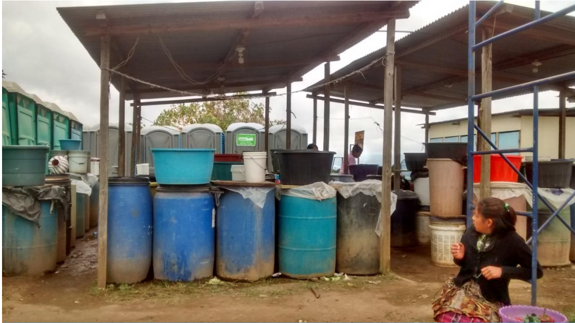
Pilas, duchas e inodoros móviles comunales en colapso. Imagen 9: fuente, propia.
