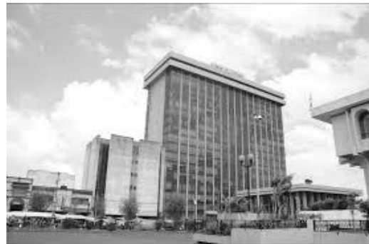
Figura 26, Edificio de Finanzas, Fotografía por: Anónimo. sf
