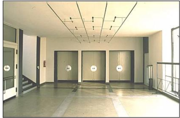
Figura 43, Detalle de Instalaciones. Plataforma Arquitectura. 2014
