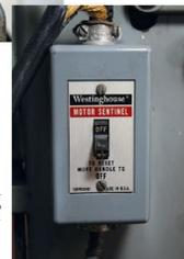
Interruptor de apagado y encendido.
