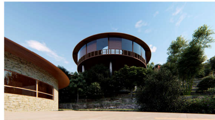
VISTA EXTERIOR DE RESTAURANTE
