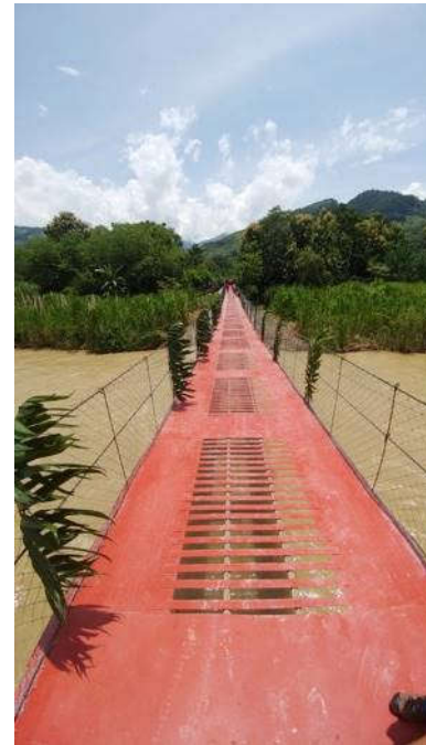
Figura 37 Puente peatonal colgante, Matucuy, Fotografía Propia
