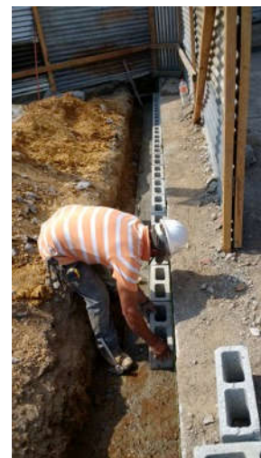
Figura 38 Construcción del Parque Central de Purulhá 2017
