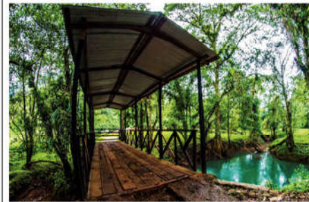
VISTA DE PUENTE VEHICULAR
