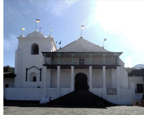
Figura 38, Elaboración propia. Fachada Iglesia Santiago Atitlán, 1547 original, siglo XX restauración [fotografía], 2017.
