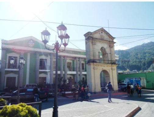
Figura 7, Elaboración propia. Exterior municipalidad de Santa Lucía Utatlán Sololá [Fotografía], 2018.
