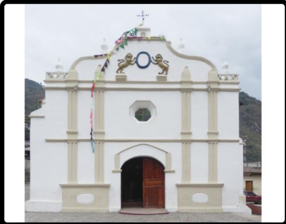
Figura 53, Elaboración propia. Fachada Iglesia Santa Catarina Palopo, 1726 original [fotografía], 2017.
