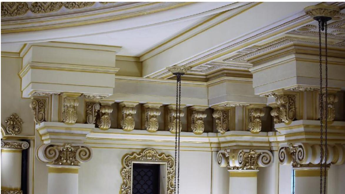
Integración de pintura en área Nor-Oeste de columnas y ménsulas.
