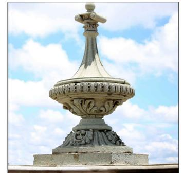
30 Unidades en el edificio, ubicados en esquinas de los torreones enmarcando los vertices de cada uno, características de deterioro uniforme entre sí, altura de 2.00 mts. X 1.10 mts de diametro.
