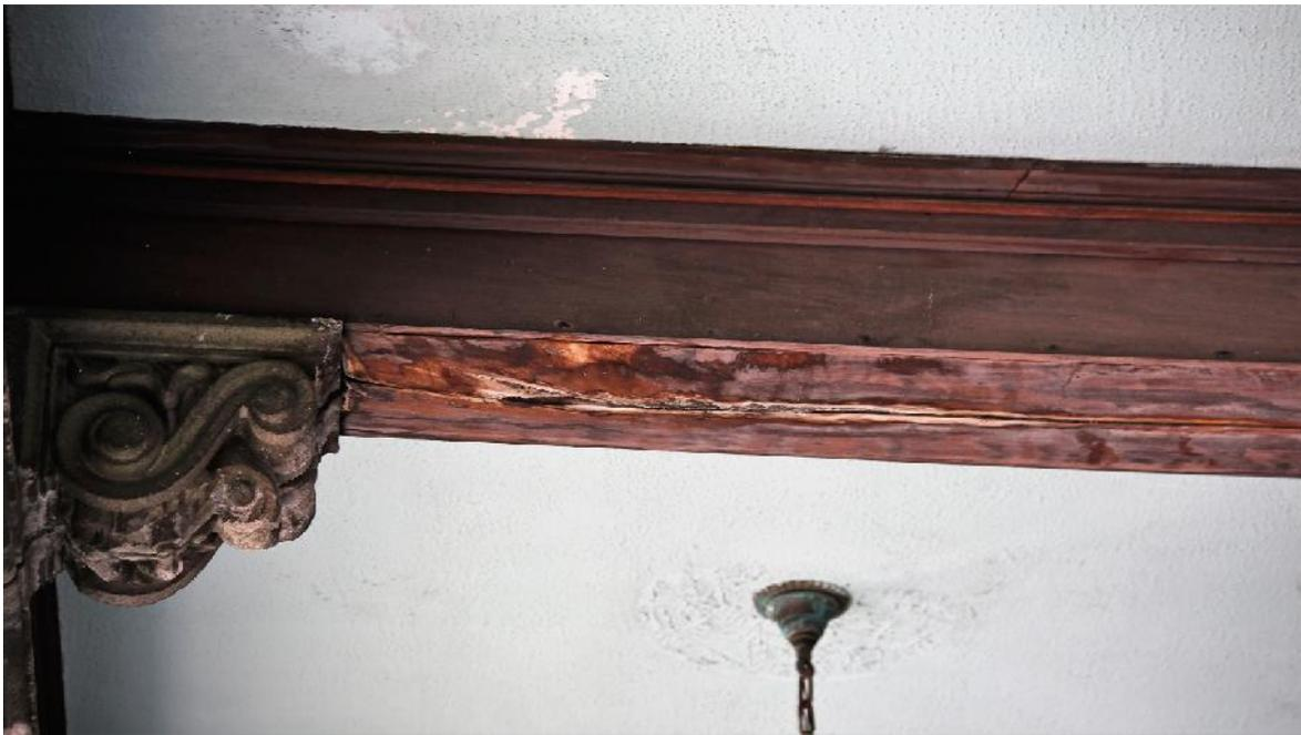
Desprendimiento en detalle de madera en columnas forradas en área de golondrinera.
