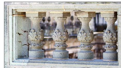
876 Unidades, en marcados dentro del area de parapeto, compuesto de granito de distintas tonalidades, arena, cemento y pigmentos. Armonizados en el capitel y base con una sisa de color amarillo en cada elemento, características de deterioro uniforme entre sí, altura de 0.50 mts.
