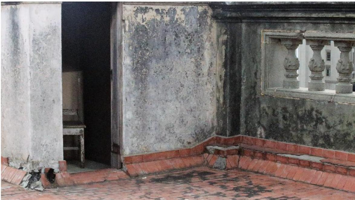
Inconsistencia de muro y debilitado por humedad.
