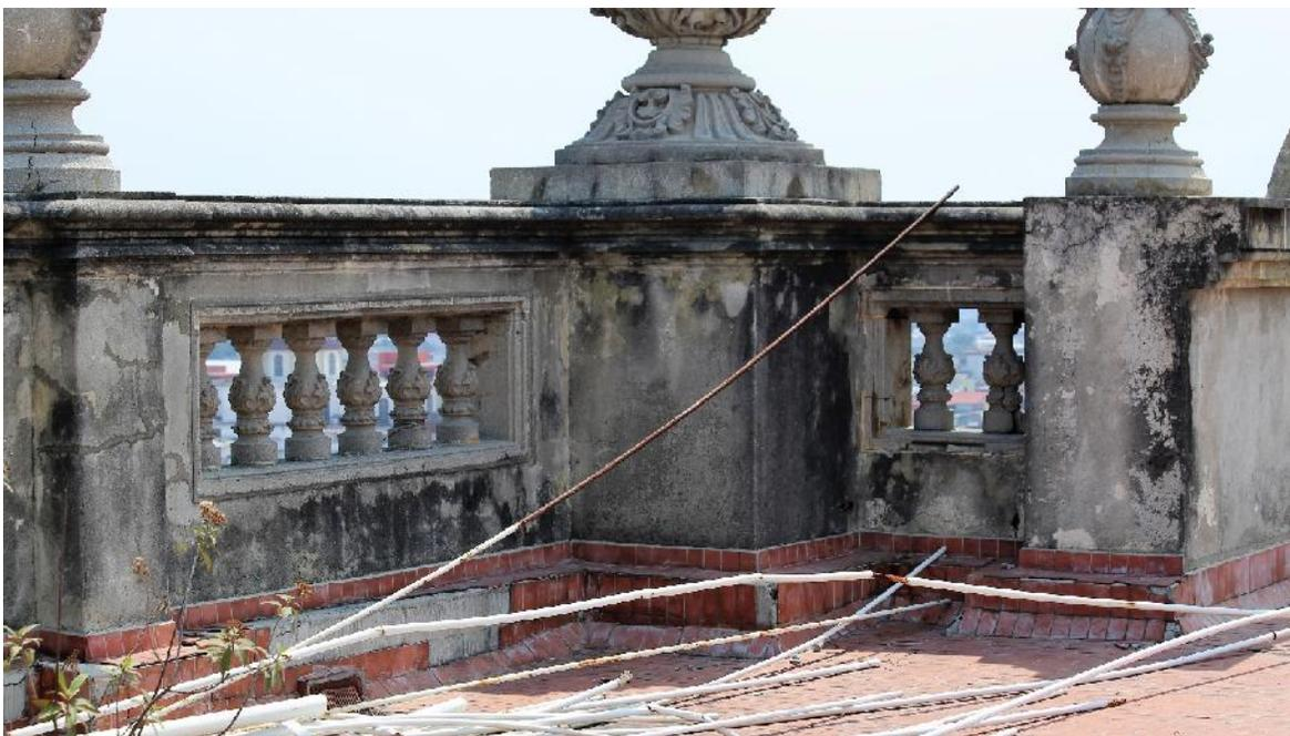
Parapeto con manchas de infiltración entre la estructura principal y el repello de acabado.
