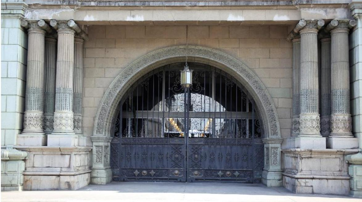
Desportilladura en parte basal de columnas y molduras en acceso por quinta calle.
