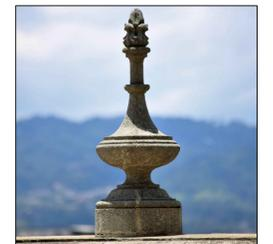
40 Unidades, ubicados en la azotea asentados unicamente en el parapeto abalaustrado, armonizando con el pinaculo tipo 2 unicamente, características de deterioro uniforme entre sí, altura de 1.10 mts. X 0.40 mts de diametro.
