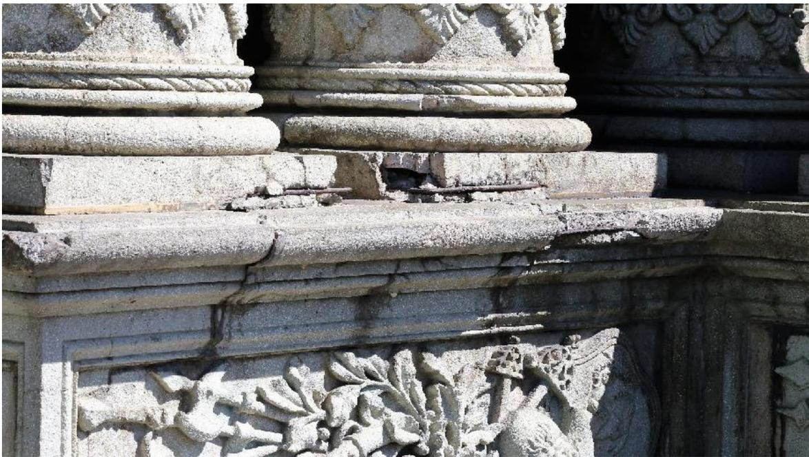
Desportilladuras graves y exposición de acero de refuerzo en bases de columnas de ingreso.
