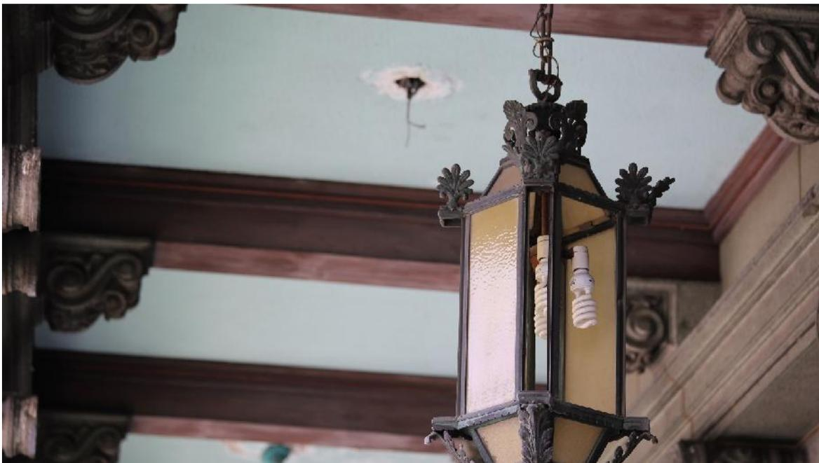
Desprendimiento de lámpara por corrosión en cadena y plafón.
