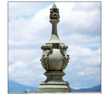
111 Unidades, ubicados en el perímetro del edificio asentados en basamentos del parapeto abalaustrado, características de deterioro uniforme entre sí, altura de 1.70 mts. X 0.60 mts de diametro.
