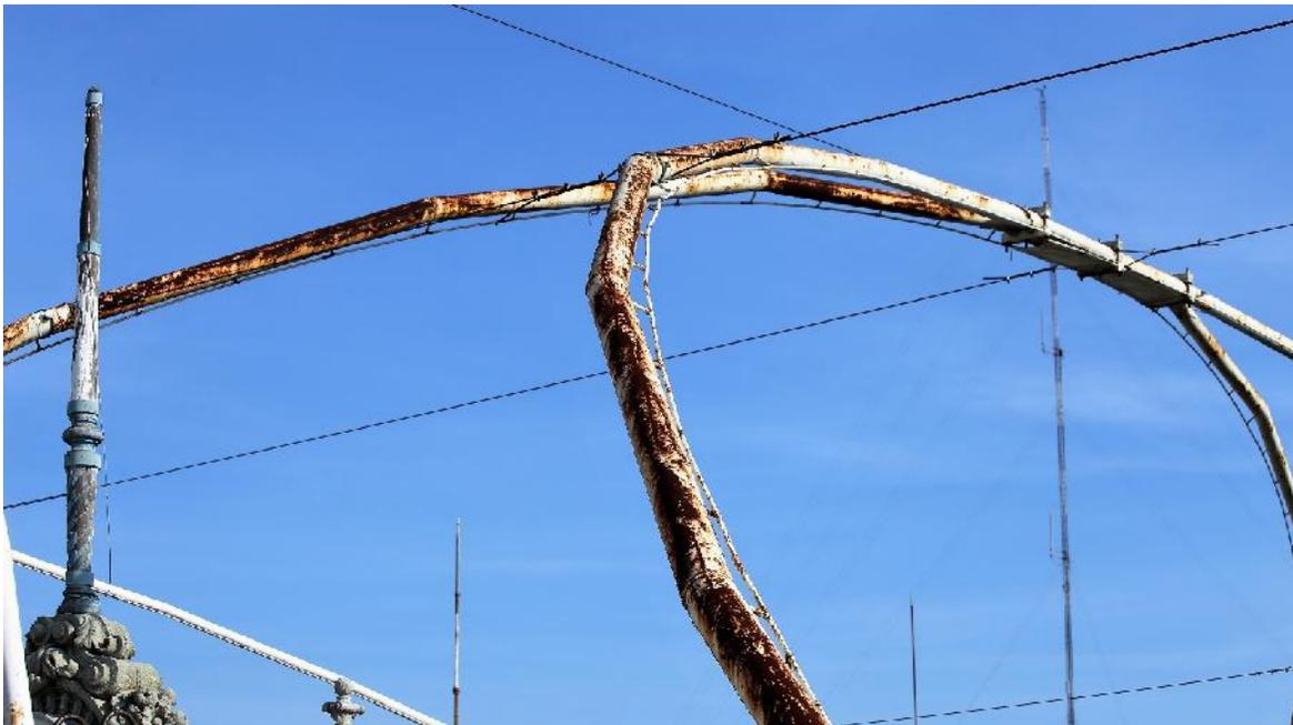
Estructura metálica de cubierta en patio de la Cultura manifestación de oxidación.
