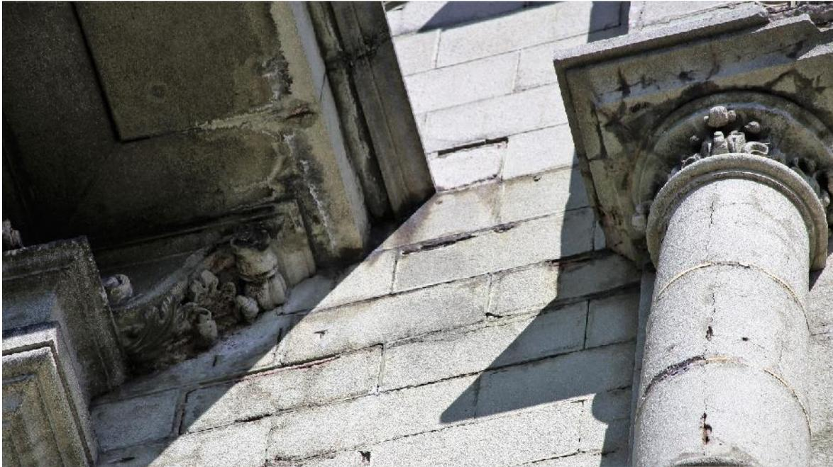
Deterioro notable en fachaleta plana módulo central en segundo nivel.
