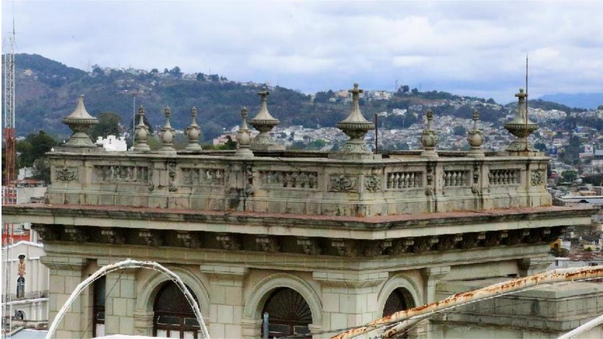
En todo el parapeto perimetral y pináculos de remate se evidencia material inconsistente.
