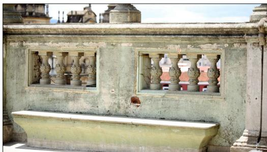
605.85 metros lineales, ubicado en el perímetro de azotea y de torreones armonizando con elementos denominados como balaustres, por el interior, se compone por un repello mas cernido y por el exterior por un compuesto de granito de diferentes tonalidades envolviendo su estructura principal la cual esta elaborada por ladrillo en colocacion de lazo y lizón, características de deterioro uniforme entre sí, altura de 1.70 mts. X 0.40 mts de ancho.
