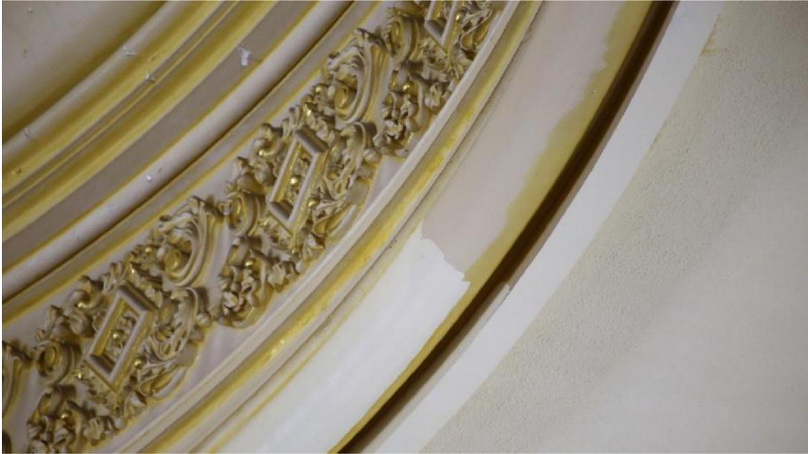
Integración de pintura en detalles varias en área de anillo en cúpula.
