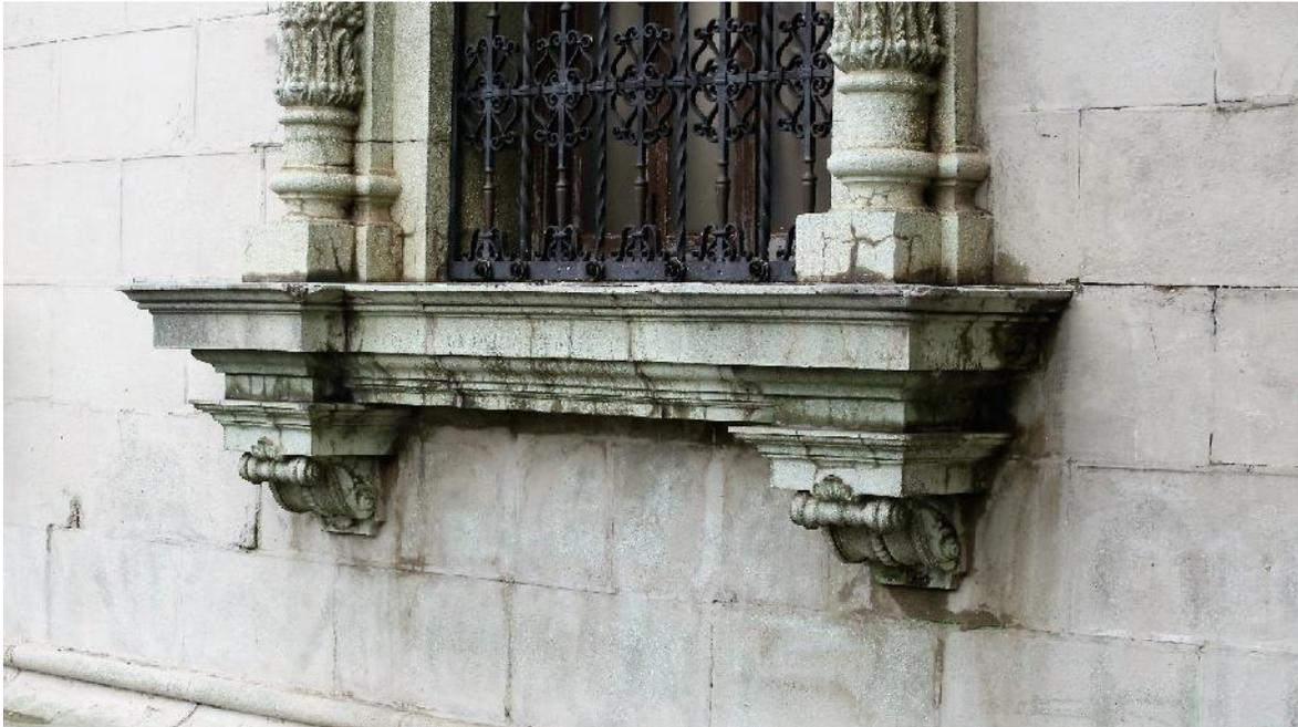
Características de infiltraciones de humedad en detalles varios en ventanas.
