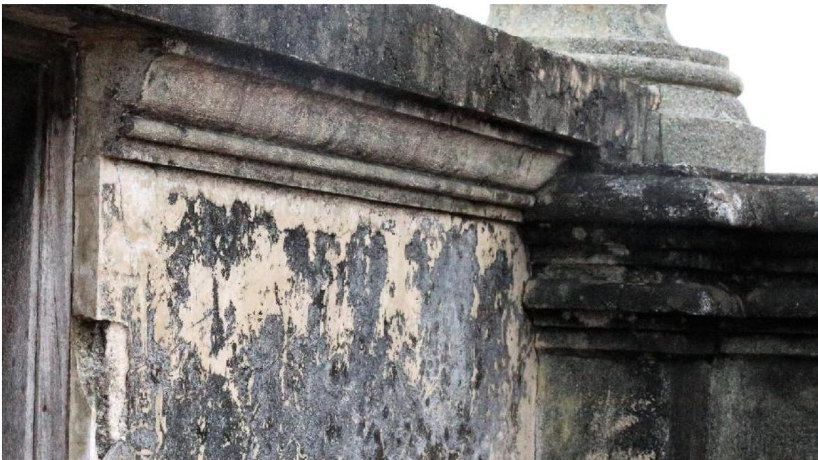
Muro con alto grado de deterioro por humedad impregnada.
