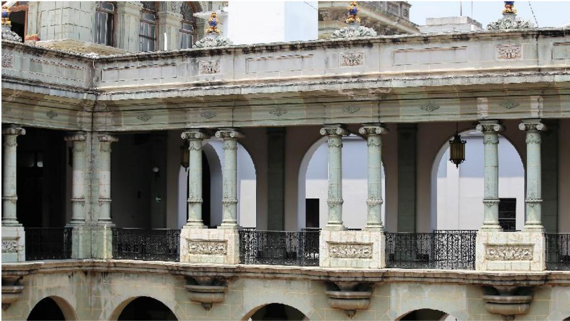
Manchas de humedad en fuste de columnas en junta constructiva en patio de la Cultura.
