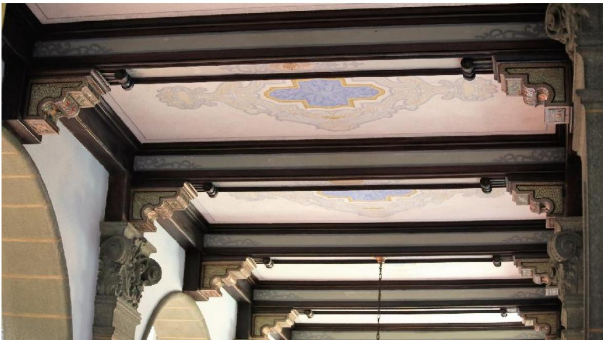
Losa de corredor Sur del segundo nivel con evidencia de craquelación en las pinturas de cielo
