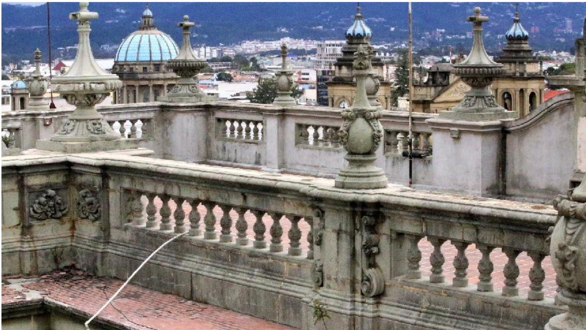
En toda el área externa del parapeto manifiesta suciedad impregnada en el granito compuesto.
