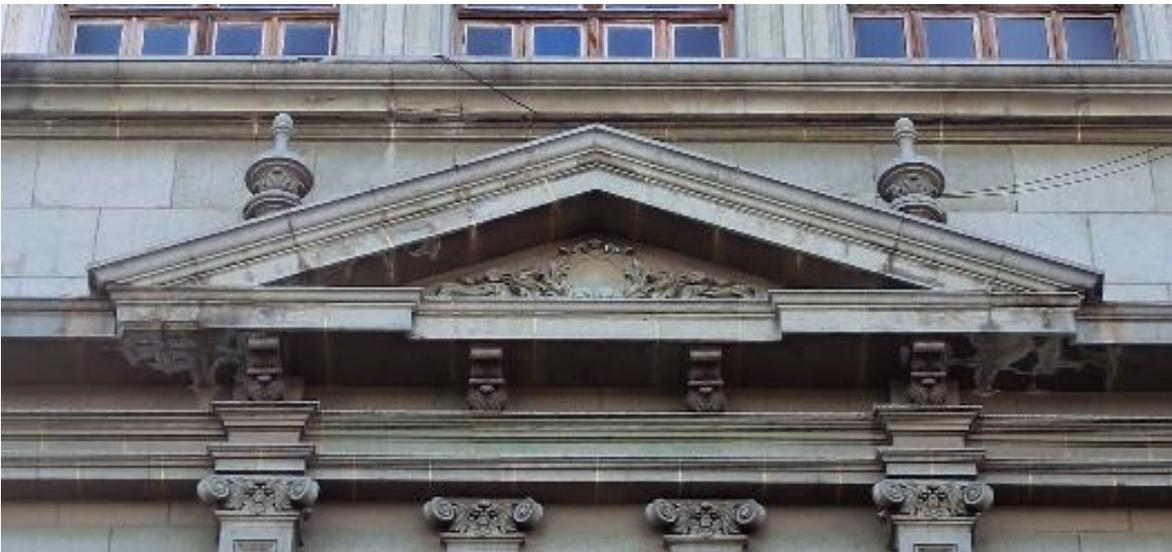
Frontón triangular, dentro estos espacios es recurrente la manifestación de humedad y desprendimiento en las molduras por el alto grado de deterioro.
