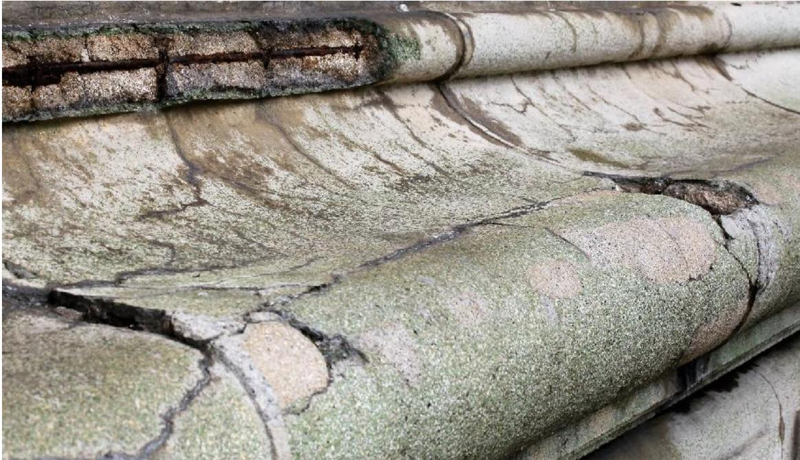
Fachaleta ondula en sócalo en todo lo largo del módulo, manifestación de acero de refuerzo con alto grado de corrosión y craquelaciones varias.
