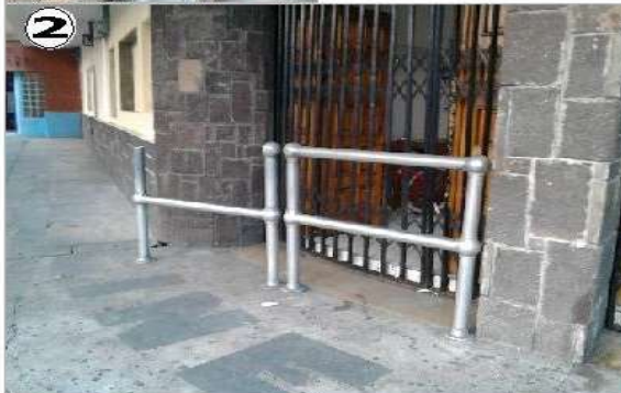
Foto 1 y 2, Daños en unifila que tiene uniones esféricas, daños causados por vandalismo y desgaste por la frecuencia de uso.
