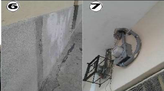
Foto 6 y 7, Zócalo de granito lavado en la foto se puede observar que es el original, en la foto No.7 se puede ver malas prácticas al hacer instalaciones.
