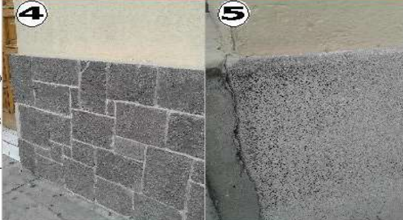
Foto 4 y 5, Cambio de zócalo de piedra morlón instalada sobre el zócalo de granito que es el original gracias a que dejaron una parte libre sin instalar.
