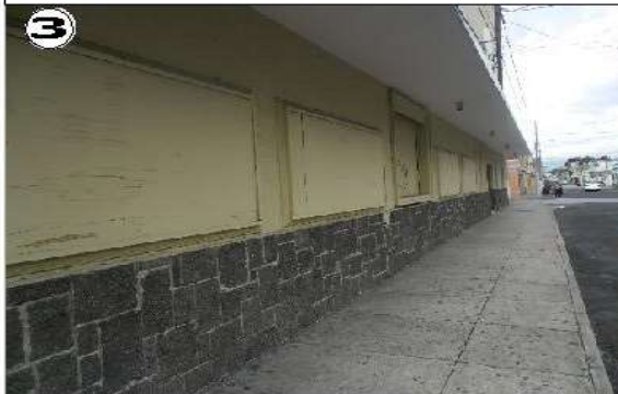
Foto 3,8 y 9, alteraciones en carteleras mal mantenimiento, los protectores de las carteleras fueron desmontadas y hicieron murales bajo los vanos los marcos fueron pintados de blanco.
