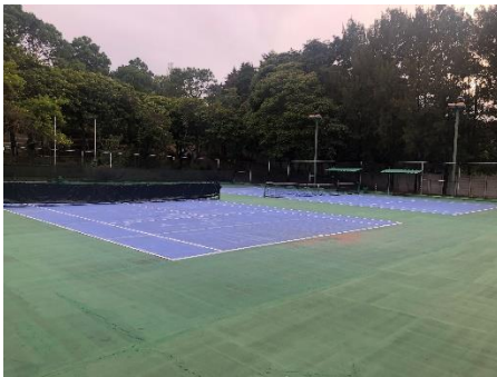
Cancha de tenis Fuente: Imagen propia.
