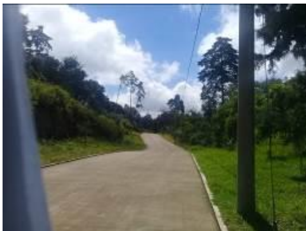
Figura 17. Camino pavimentado con concreto (Sector 2) dentro del Condominio Bosques del Mirador zona 6 de Mixco, el cual ya se encontraba establecido previo a la entrada en vigencia del Plan Maestro de la RFPMCA.
