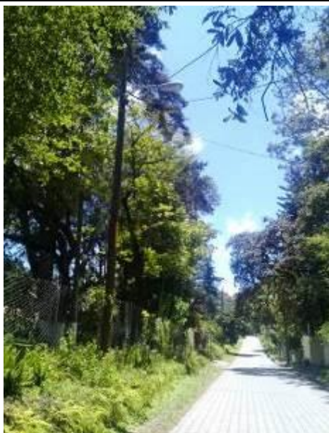
Figura 28. Poste de madera de 6.00m de alto utilizado para el alumbrado público pero de las líneas de energía que conduce se deriva hacia cada una de las acometidas de las viviendas.
