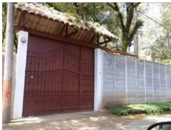
Figura 18. Construcción ya realizada de vivienda unifamiliar y su muro perimetral con su respectiva acometida eléctrica (contador) ubicada dentro de los Residenciales Campesinos El Encinal.
