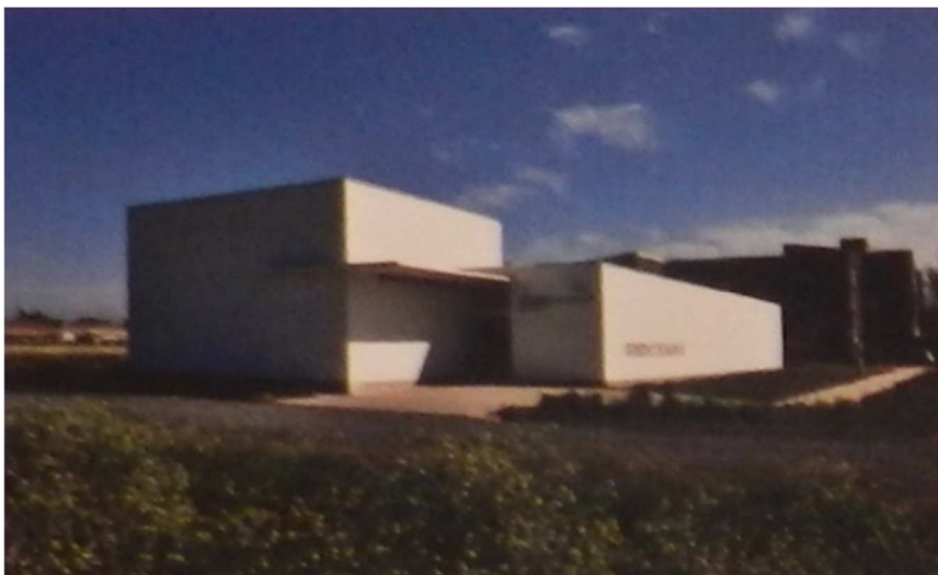
IMAGEN 17. EXTERIOR DEL CENTRO DE SALUD VILLA GOB.
