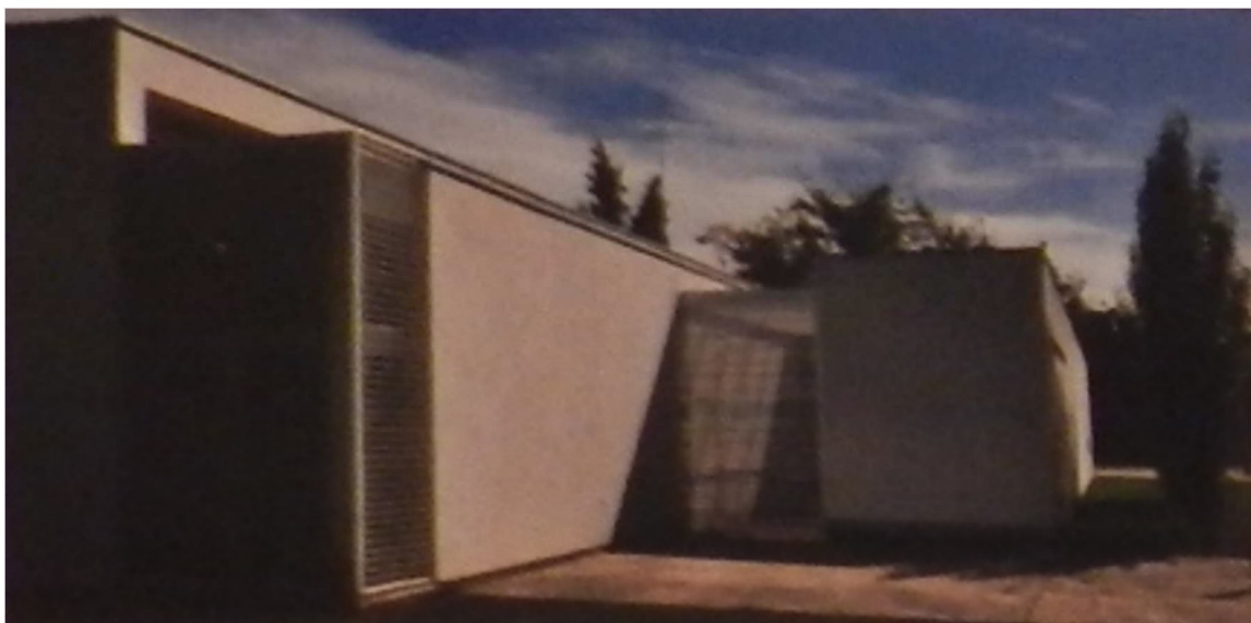
IMAGEN 19. EXTERIOR DEL CENTRO DE SALUD VILLA GOB.
