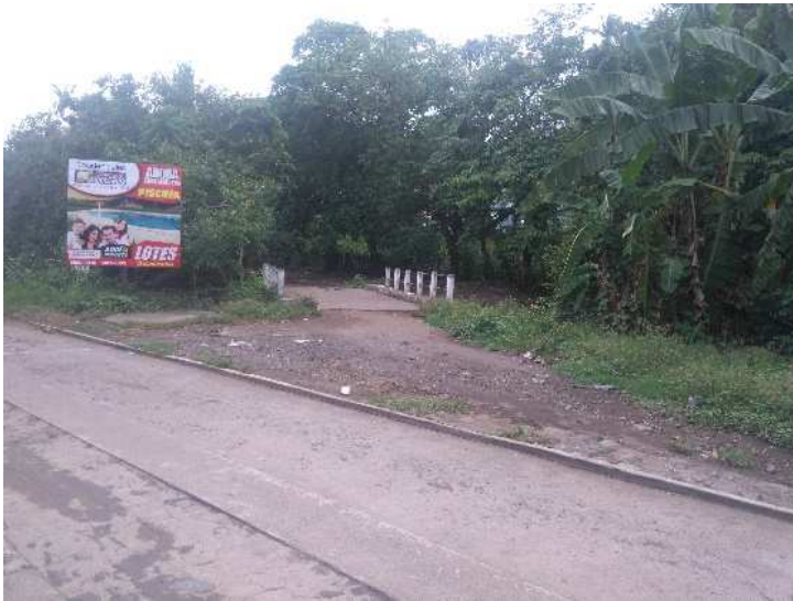
Calle Xulá, vista de puente de ingreso al terreno.
