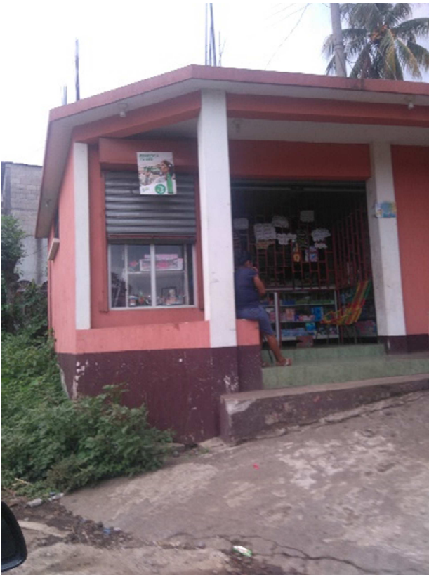
Abarrotería con muros y losa de concreto. Fuente: fotografía propia.
