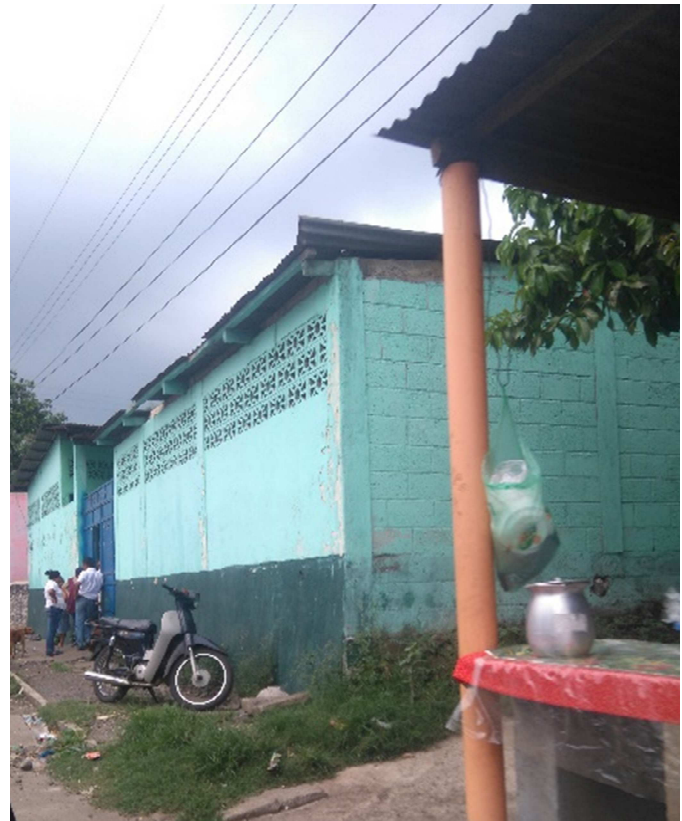
Escuela de block visto y techo de lámina. Fuente: fotografía propia.
