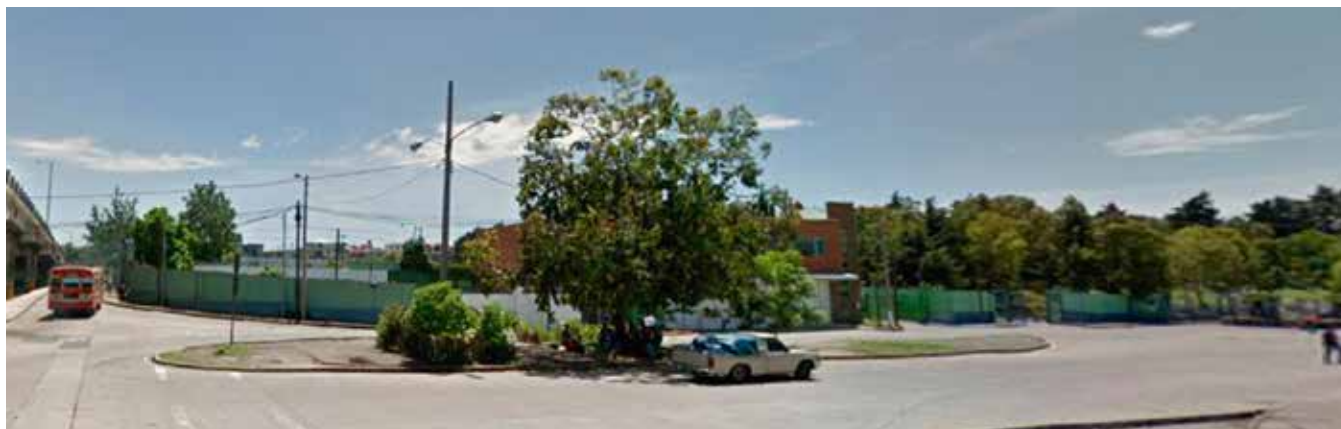
2. VISTA INGRESO PRINCIPAL 52 CALLE
