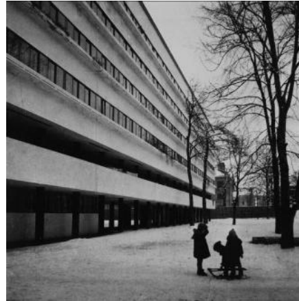
Fotografía 3 Edificio Narkomfim Fuente: https://es.slideshare.net/seasondays/constructivismo-1557350
