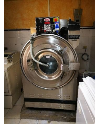
Fotografía 19 Lavandería. Fuente: Elaboración propia.
