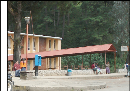
③ Ingresso ambulatorio
