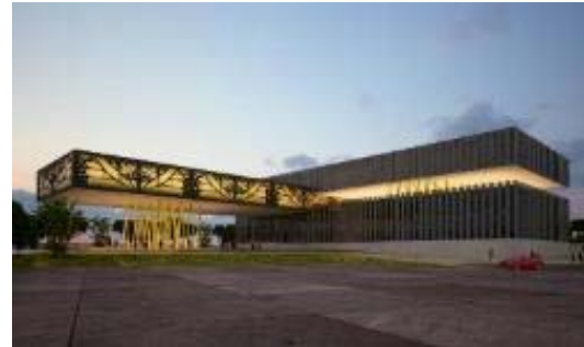
Figura 5 - Imagen de Arquitectura Industrial, Arquitectura industrial de occidente SA de CV- construcción de parques industriales, https://guiamexico.com.mx/empresas/arquitectura-industrial-de-occidente-sa-de-cv-construccion-de-parques-industriales.html
