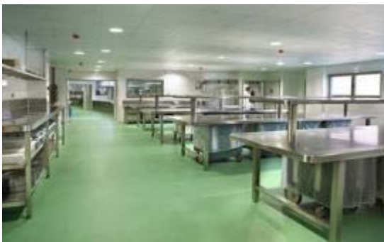
Figura 28- Pisos epóxidos sanitarios en rastros, http://www.pisosepoxicosindustriales.mx/sanitarios-antisepticos/para-rastros-obradores-y-carnicerias.html
