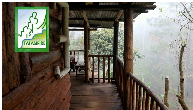
Imagen 20 Acabados de madera con barniz
