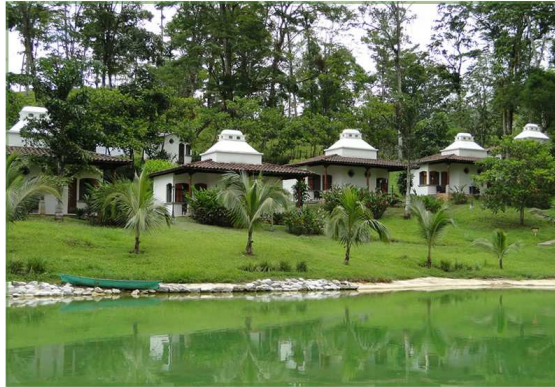
Imagen 34 Dormitorios con cimientos de concreto
