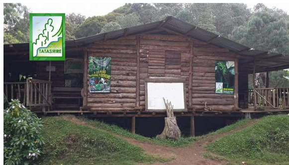
Imagen 19 Vista demostrando los cimientos
