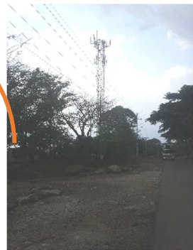
SEÑAL DE TELÉFONO
