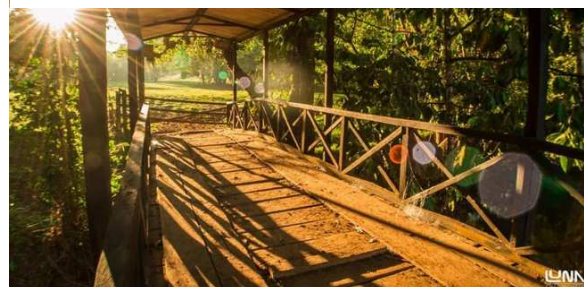
Imagen 29 Puente construido con madera
