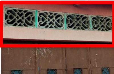
Ilustración 33 Vivienda Fuente: fotografía propia
