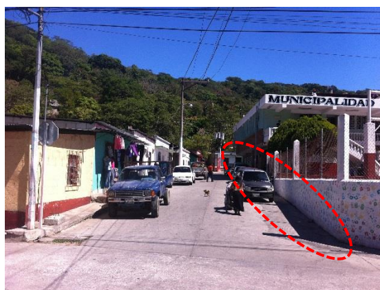
Foto No.57, Falta de banqueta, Fuente: Propia
