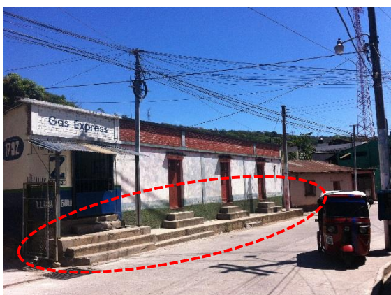
Foto No.56, Gradas en vía Peatonal, Fuente: Propia
