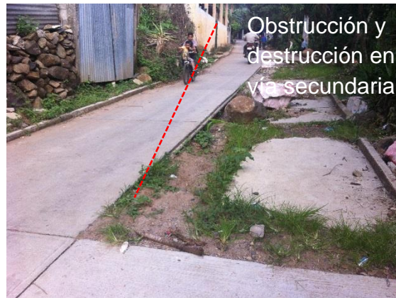
Foto No.31, Estado de calle hacia el Mangón, Fuente: Propia
