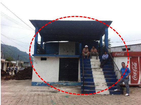
Foto No.66, Construcción en zona vial, Fuente: Propia
