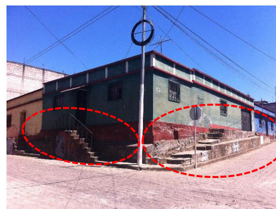
Foto No.63, Interrupción peatonal por gradas, Fuente: Propia
