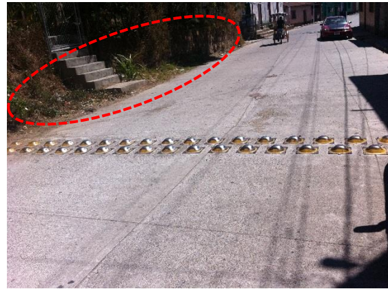
Foto No.67, Falta de banquetas, Fuente: Propia
