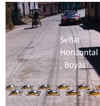
Foto No.76, Reductores de Velocidad Fuente: Propia
