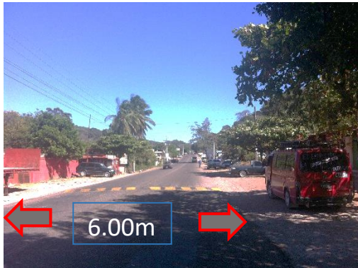
Foto No. 14, Vía Primaria CA-8, Fuente: Propia
