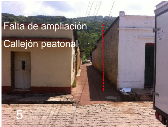
Foto No.38, 2ª calle callejón reducido a 2m, Fuente: Propia
