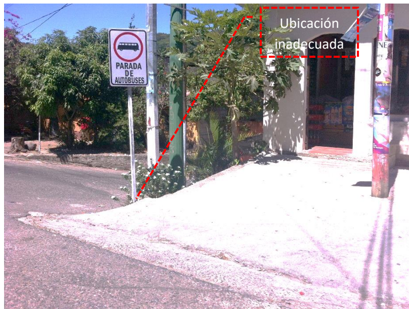
Foto No. 79, Parada de Bus sin carril de desaceleración, Fuente: Elaboración propia
