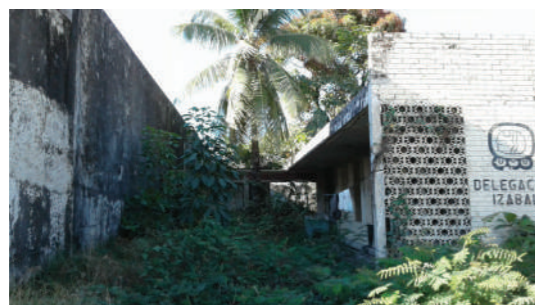
SECTOR CUBIERTO DE VEGETACIÓN DEBIDO A LA FALTA DE USO. LOS ÁRBOLES EXISTENTES SERÁN TOMADOS EN CUENTA PARA INTEGRARLOS A LA NUEVA PROPUESTA DE REUTILIZACIÓN DE LA EDIFICACIÓN.
