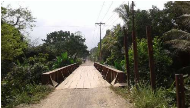
PUENTE MILLA 3: Se localiza en una de las áreas con mayor vegetación, reconstruido con madera para permitir el acceso de un extremo a otro.
