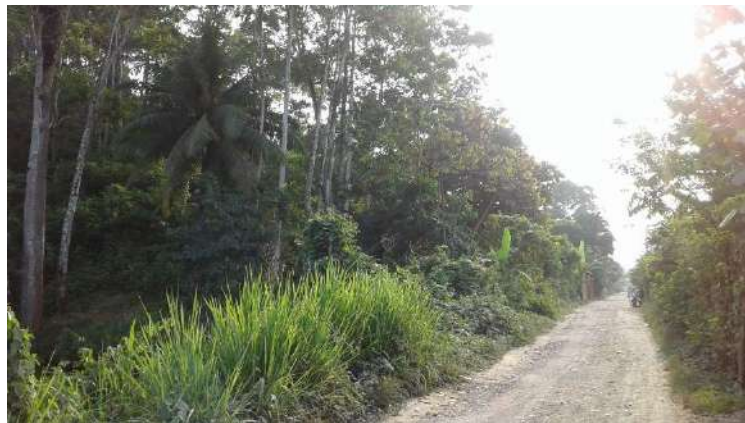
TRAMO FERROVIARIO: Sector cercano a la milla 8 donde predomina la vegetación en el área.
