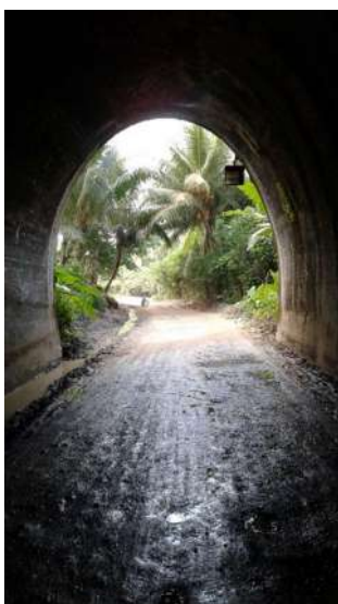
INTERIOR TÚNEL: La iluminación y ventilación natural accede al interior del túnel, se cuenta con iluminación instalada en los dos extremos que funciona únicamente por las noches.
