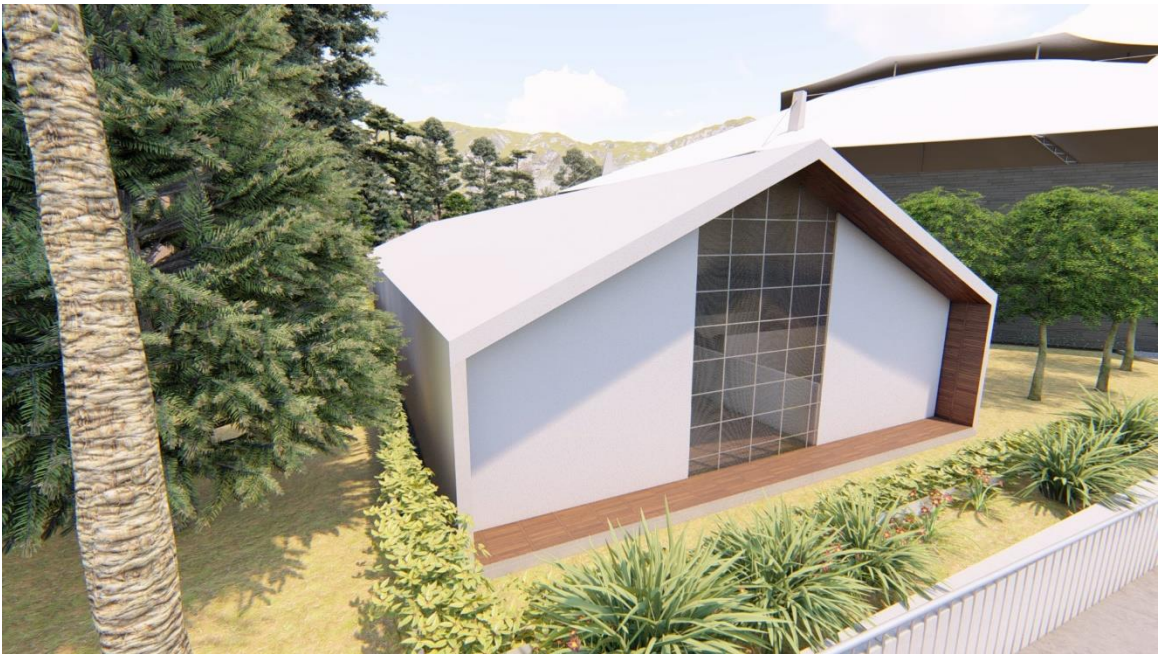
VISTA 14 FACHADA ESTE DE CABALLERIZAS.
