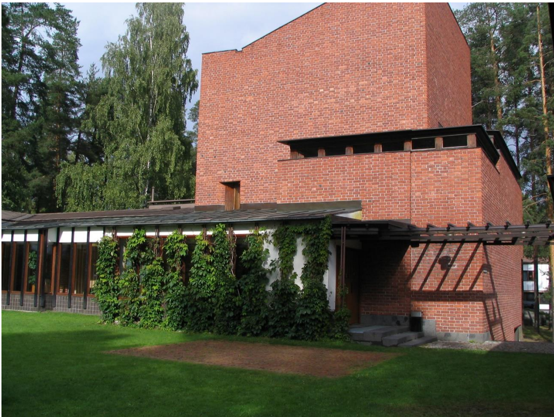
Ilustración 3 Edificio Municipal De Saynatsalo, Finlandia Arquitecto: Alvar Aalto Obtenido el 10 de diciembre de 2018 de: https://commons.wikimedia.org/w/index.php?curid=2675563
