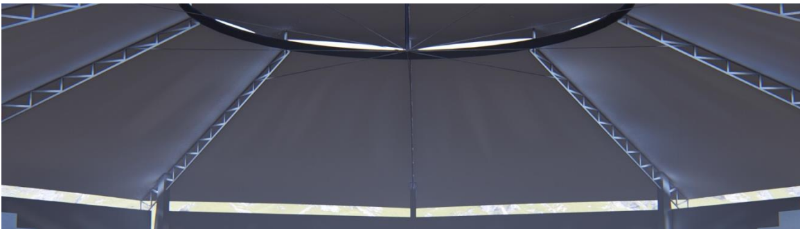
Ilustración 73 Vista de estructura del coliseo, elaboración propia.
