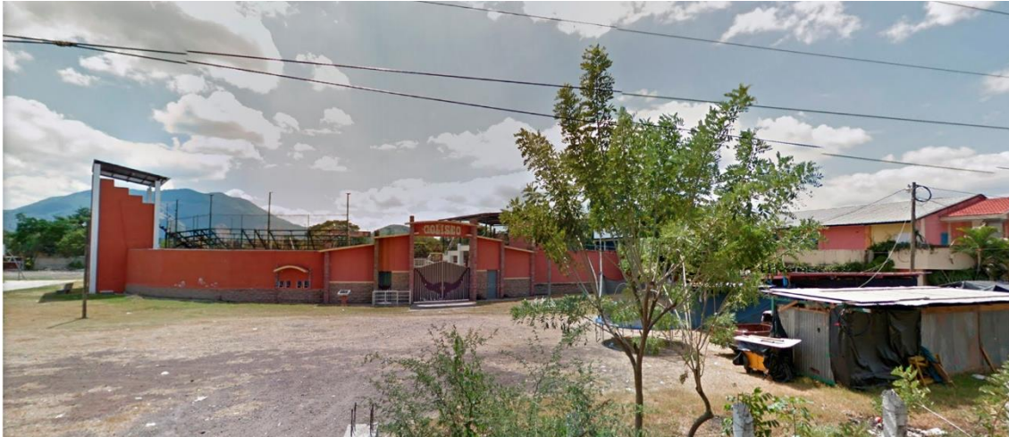
Ilustración 14 Fachada del Coliseo Municipal de Ipala, Chiquimula, Guatemala. Google Street View
