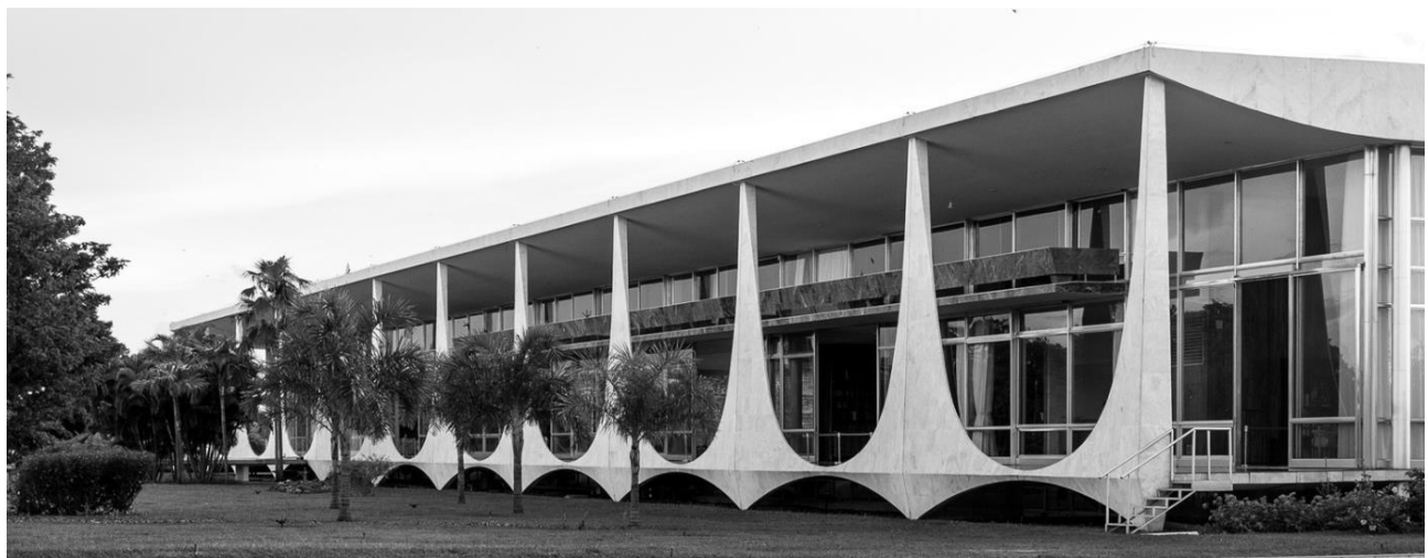
Fotografía - Fachada posterior del edificio.
