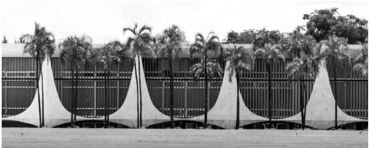
Fotografía - Fachada principal de edificio.
