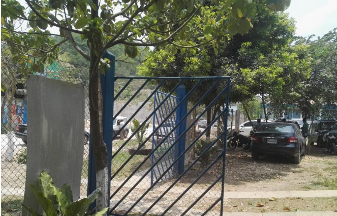
Ilustración No.42 Terreno e infraestructura del MAGA en Santa Elena, Flores, Petén. Abril 2018 Fotografía propia Hugo Leonel Contreras Hernández
