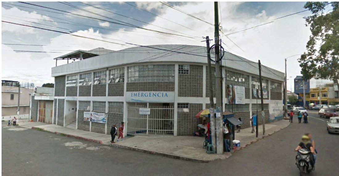
Ilustración 24. Fachada de CAP Colonia Bethania. Fuente: Google Earth.
