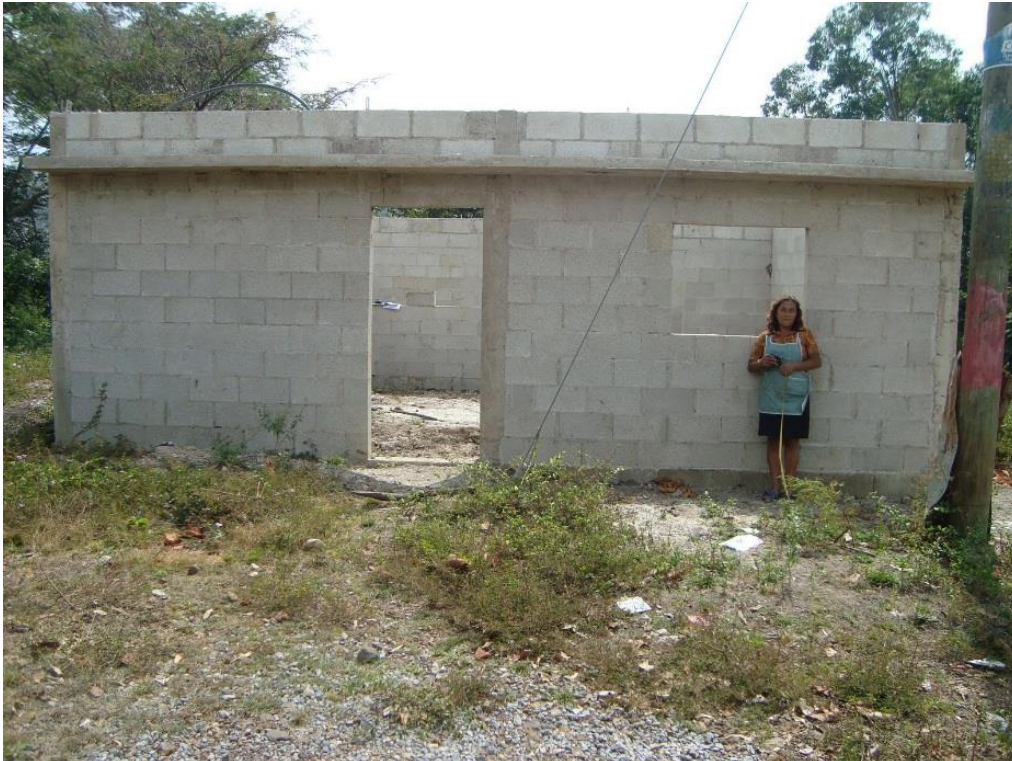
Imagen: autoconstrucción de la Biblioteca comunitaria "Rodrigo Asturias" por parte de las mujeres de la comunidad El Obrajuelo, Villa Canales. Imagen tomada de la página web de la red de bibliotecas comunitarias http://reddebibliotecascomunitarias.blogspot
