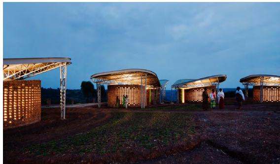
FIGURA 12 Vista nocturna de módulos, permitiendo observar la relación entre los muros y la estructura. Fuente: www.plataformaarquitectura.cl
