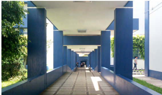
FIGURA 33 Caminamiento central techado del INTECAP-zona 7 Guatemala, Fotografía Brandon Linares
