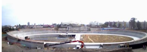
Fotografía No. 19: Construcción del Velódromo de 250ml. del Centro de Alto Rendimiento de Videna
