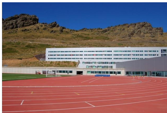
Fotografía No. 36: Centro de Alto Rendimiento para entrenamiento en altura CSD Fuente: http://carsierranevada.com
