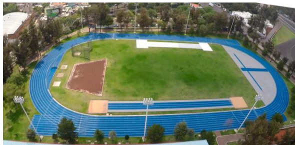
Fotografía No. 28: Pista de Atletismo del Centro de Alto Rendimiento CNAR
