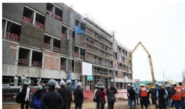
Fotografía No. 18: Construcción del edificio de residencia del Centro de Alto Rendimiento de Videna
