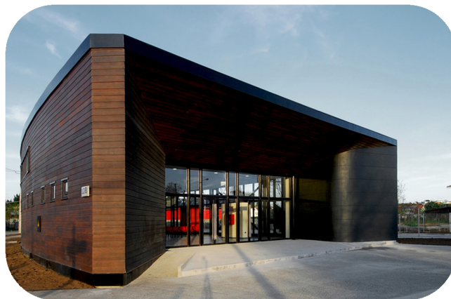
Figura 42. Fotografías Terminal de buses Los Lagos Tomadas por TNG Arquitectos
