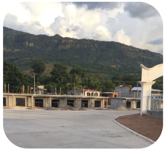
Figura 2. Locales en construcción que pretenden ser para compra/venta de granos básicos, Fotografía propia 2018
