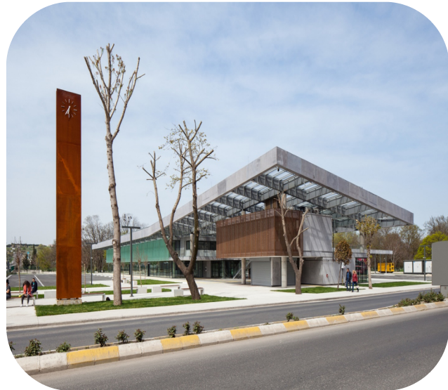
Figura 40. Fotografías de estación Luleburgaz. Tomada por Engin Gerçek, Ahmet Kazu
