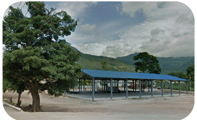
Figura 53. Fotografía hacia las galeras que están actualmente en el terreno. Elaboración propia 2018.
