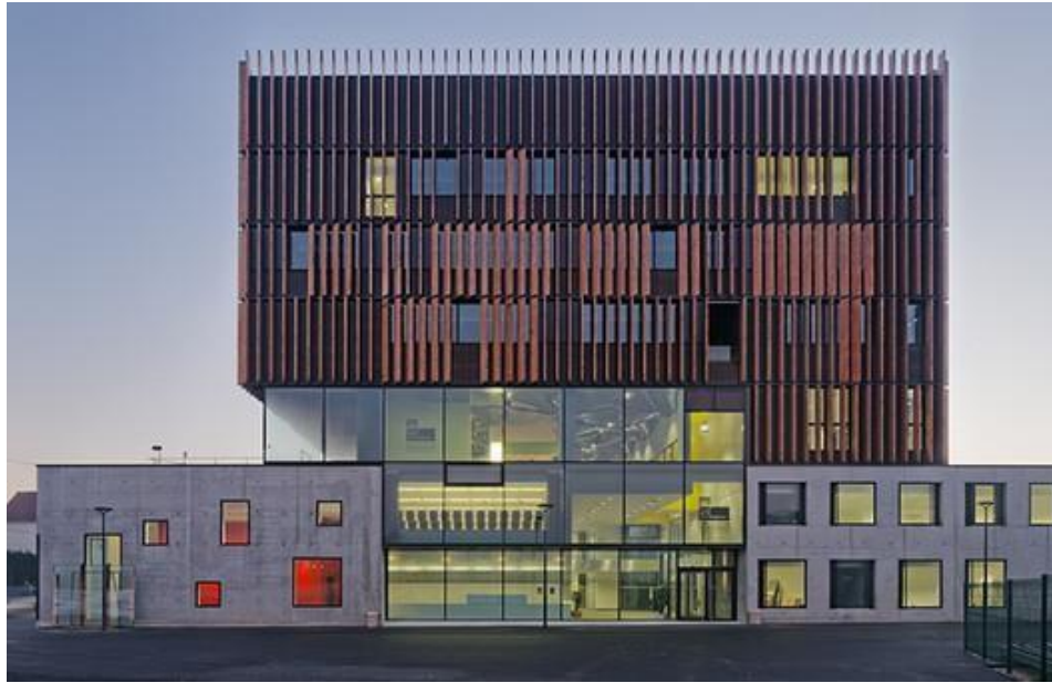
Imagen 8: Fachada Centro Tecnológico Mantois
