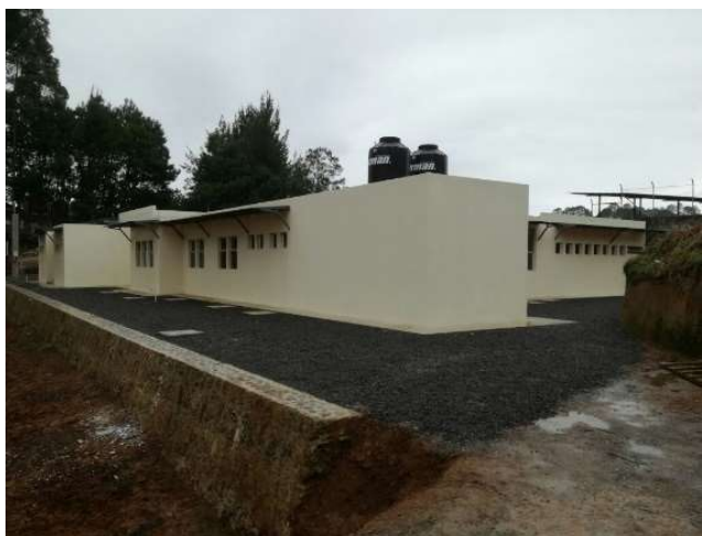
Fotografía 32: Hospital de ojos en construcción. Fuente propia 2017
