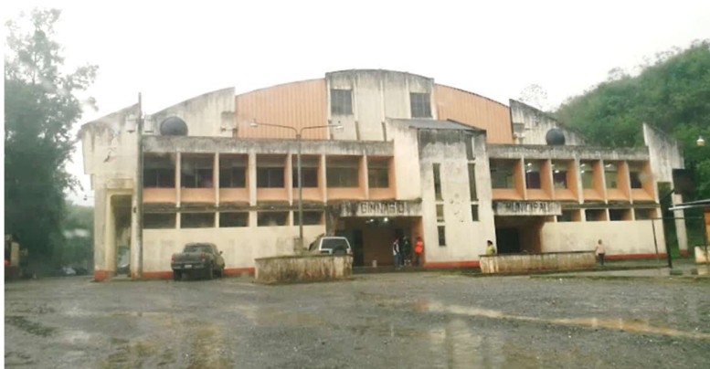
Fotografía 7: Gimnasio Municipal. Fuente: Elaboración propia (julio 2017)
